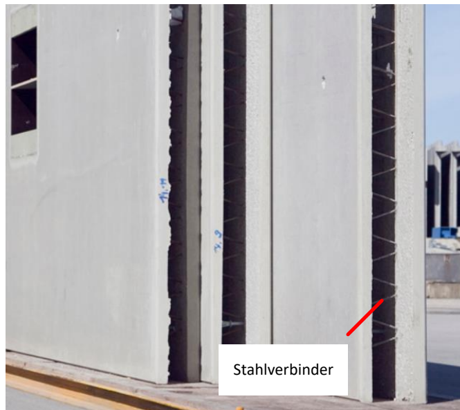
Bild 2: Einfache Plattenelemente mit Stahlverbindern
