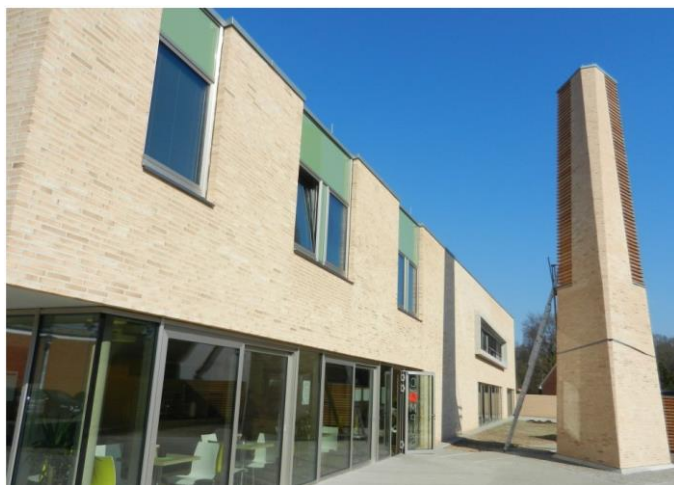
Bild 4 Klinkerbetonfassade - Kirche auf dem Uni-Campus in Vechta
