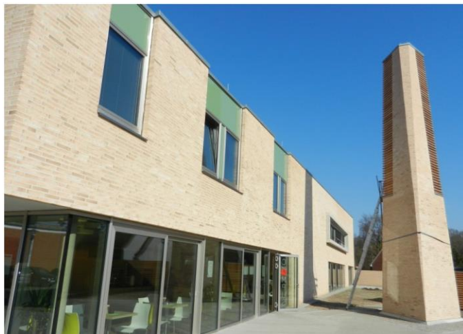
Bild 5: Sichtbetonfassade - Kirche auf dem Uni-Campus in Vechta
